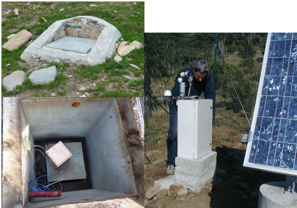
Figura 36 Esempio di stazione sismica (sinistra: pozzetto con sensore – destra: armadio acquirente).
