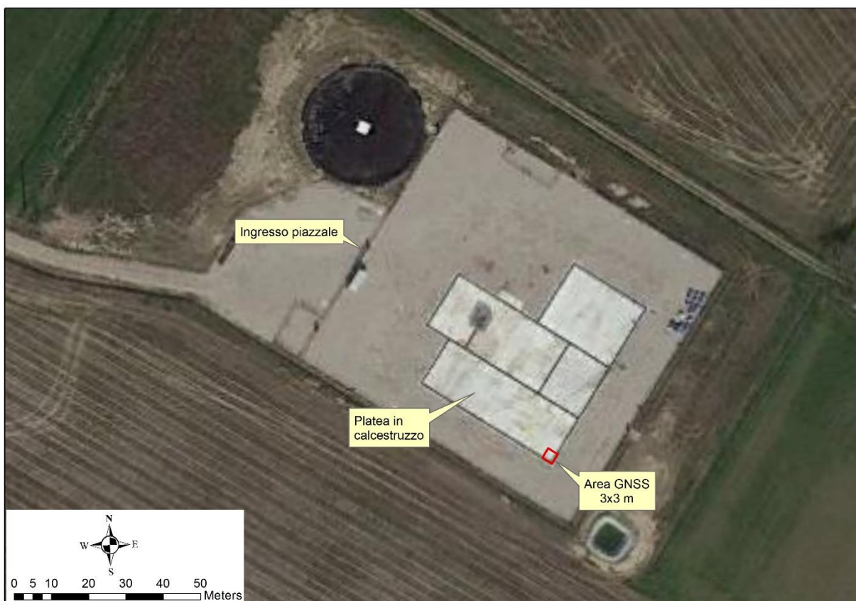
Figura 33 – posizione stazione GNSS presso area pozzo
