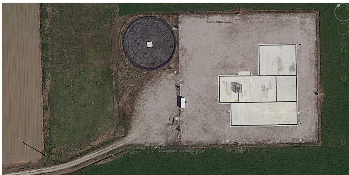
Fig. 6: Stato attuale dell'area pozzo (Fonte Google Earth).
